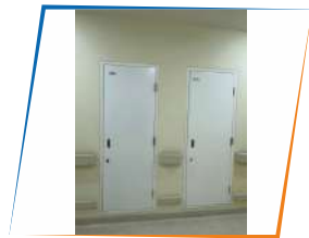
ELE & ELV SHAFT DOOR
